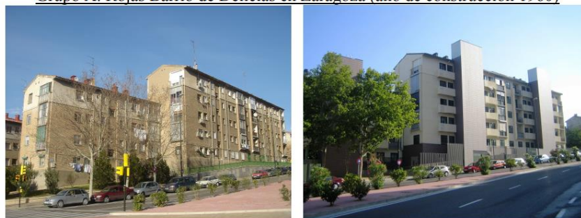
Imágenes del estado anterior y posterior a la rehabilitación (Arquitectos: Ana Morón ACXT IDOM; Constructora: Qrea Construcciones)
