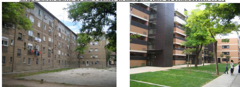
Imágenes del estado anterior y posterior a la rehabilitación (Arquitectos: Gerardo Molpeceres, MAR arquitectos; Constructora: Construcciones Moampe)
